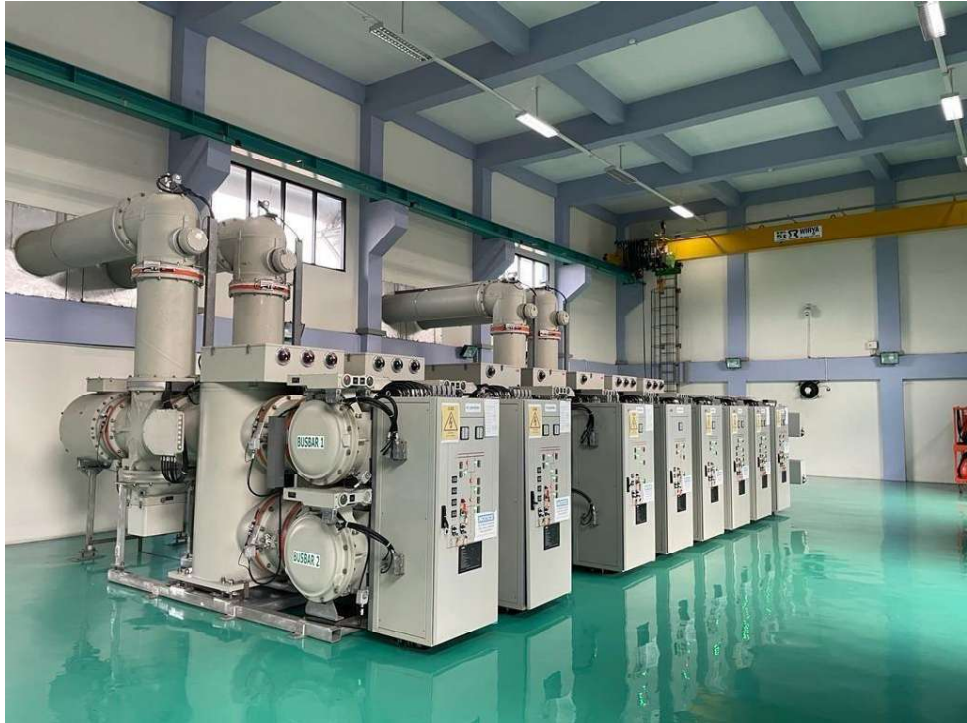
Gambar 2. 2 Gardu Induk Pasangan Dalam
