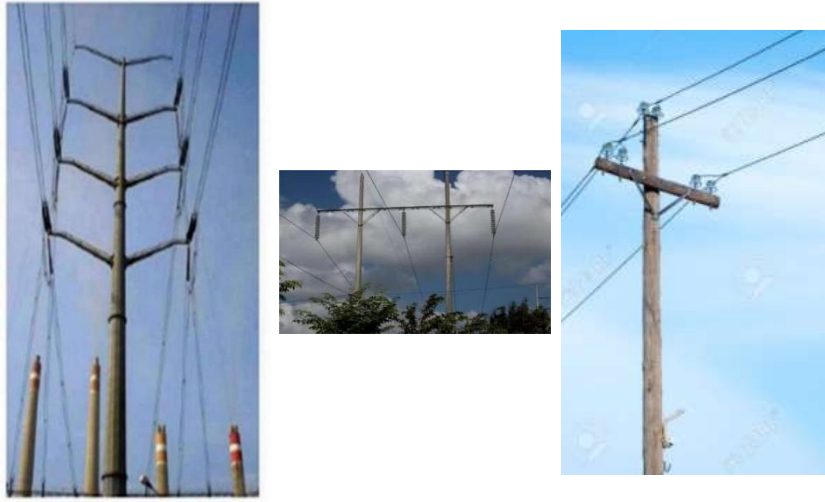
Gambar 2.9 a. Tiang Pole Baja, b. Tiang Pole Beton, c. Tiang Pole Kayu
