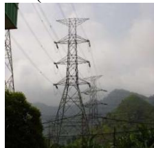
Gambar 2.6 Tiang Sudut (Angle Tower) SUTT 150 kV
