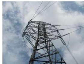
Gambar 2.6 Tiang Sudut (Angle Tower) SUTT 150 kV
