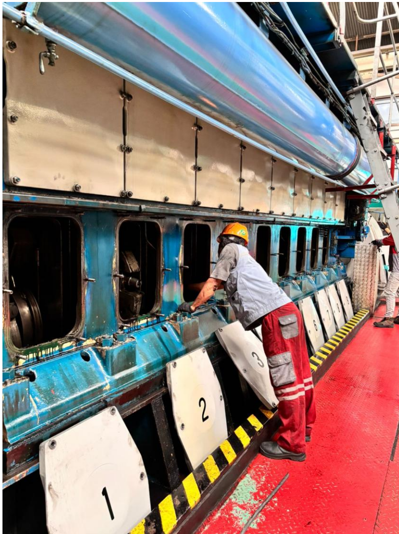
Gambar 2. 3 Pemeliharaan P4 (penggantian dudukan piston)
