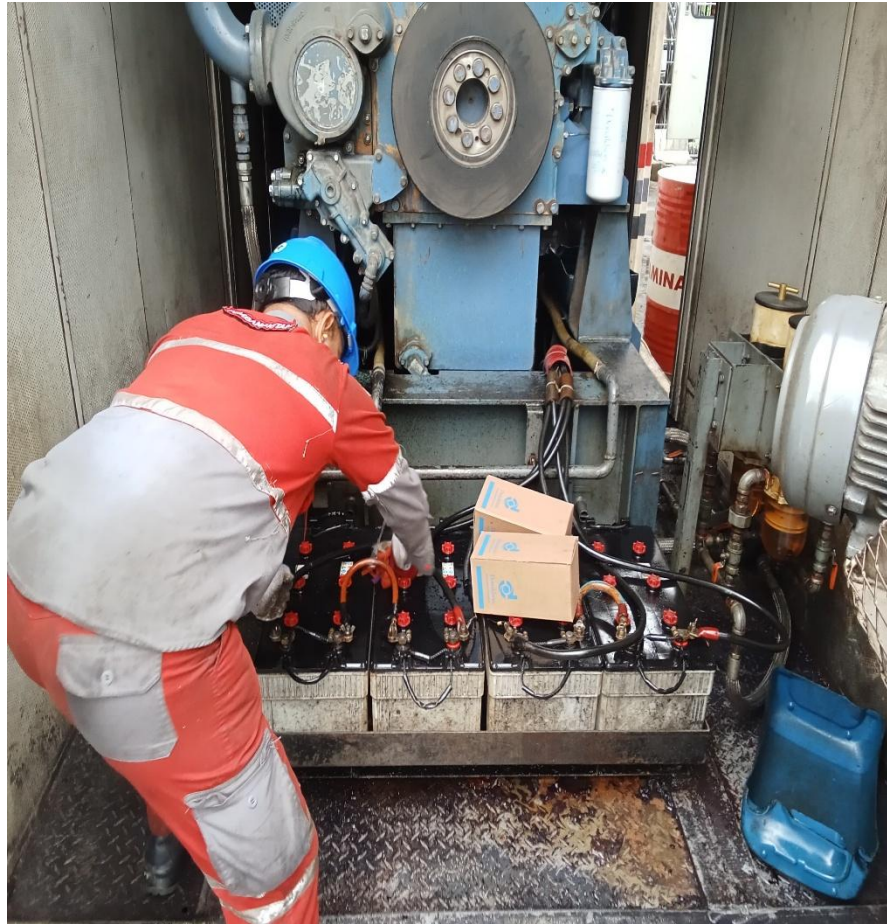
Gambar 2. 3 Pemeliharaan P1 (pembersihan batrai aki)
