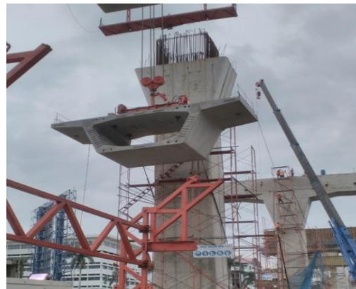
**Gambar 2.3** Pekerjaan *Erection Box Girder* dengan menggunakan *Lifting Frame*
