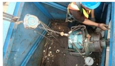
**Gambar 2.45** Pemasangan *Hidraulyc Jack*
