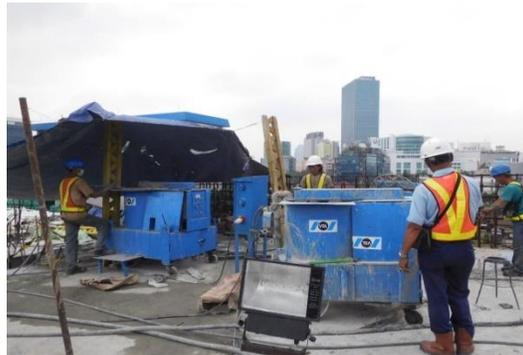
**Gambar 2.49** *Grouting menggunakan Grouting pump*
