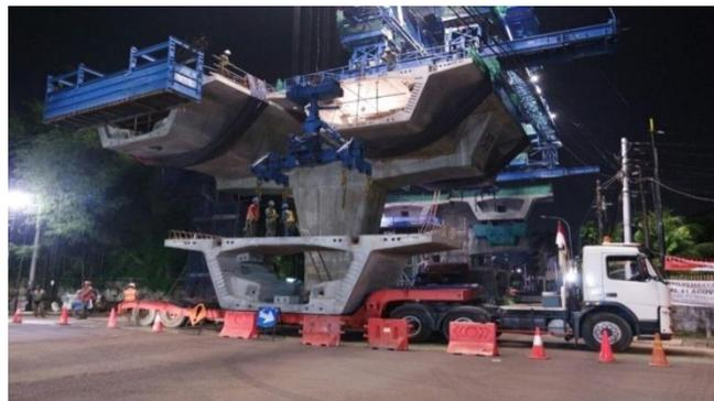
**Gambar 2.36** Trailer yang mengangkut Box Girder ditempatkan dekat lokasi
