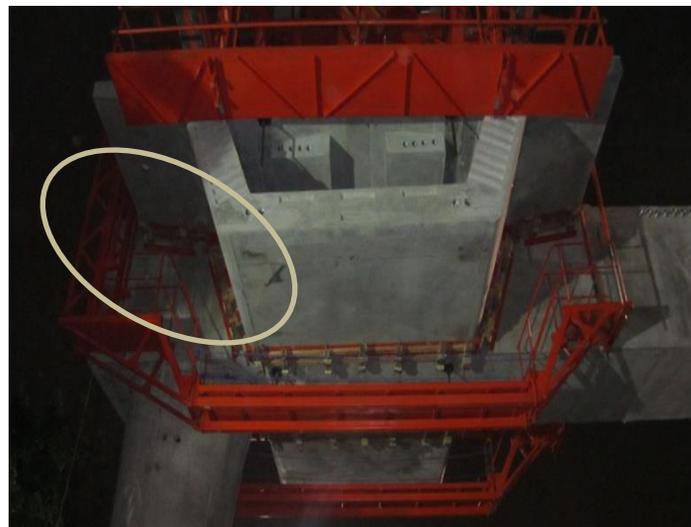
**Gambar 2.11** Proses *Stitching* dan pemasangan plat form & bekisting
