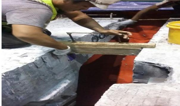
**Gambar 2.38** pengganjalan dengan kayu agar posisi stabil dan tidak menabrak ke Box Girder segmen sebelumnya
