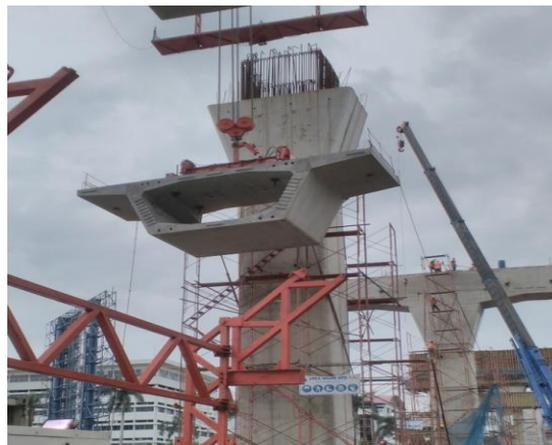
**Gambar 2.9** Proses pengangkatan *box girder*
