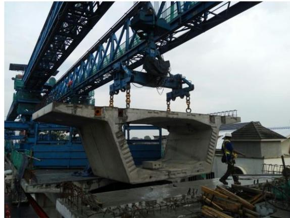
**Gambar 2.2** Pekerjaan *Erection Box Girder* dengan menggunakan *Launching Gantry*
