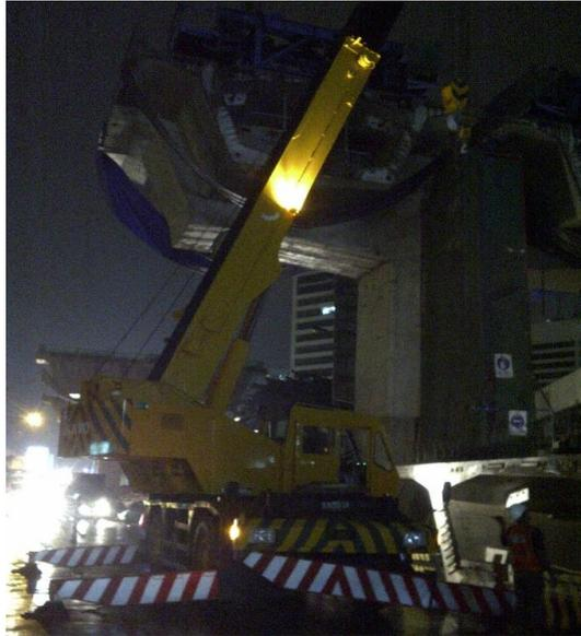
**Gambar 2.4** Pekerjaan *Erection Box Girder* dengan menggunakan *mobile crane*
