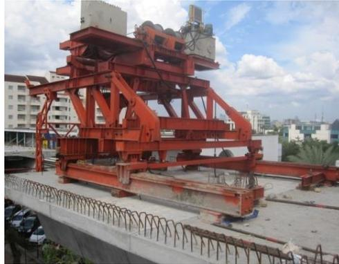
**Gambar 2.6** Pemasangan *Lifting Frame*
