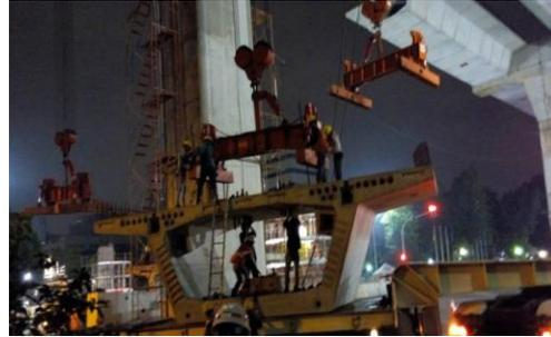
**Gambar 2.8** Proses *spreader beam* dari *Lifting Frame* diturunkan
