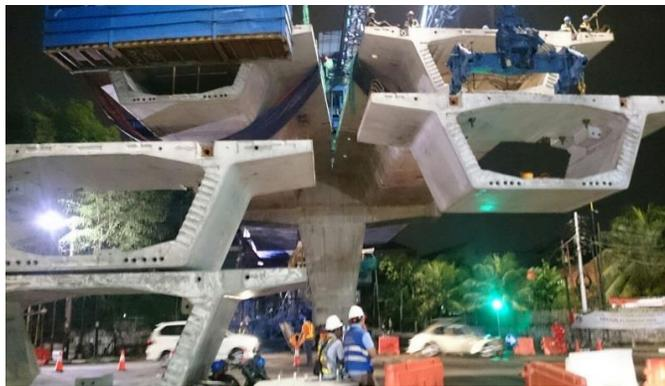
**Gambar 2.37** Pengangkatan Box Girder menggunakan konsep Balance Cantilever
