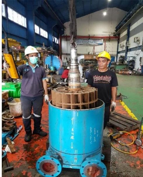
Gambar 4.6 Pengangkatan Shaft Impeller Pompa
