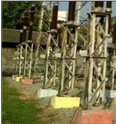
Gambar 2.13 Struktur Penyangga LA
