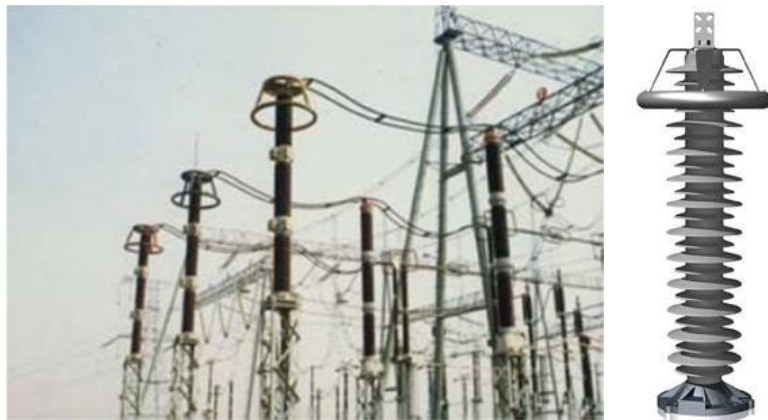
Gambar 2.5 LA di Gardu Induk dengan housing porselen (kiri) dan housing polymer (kanan)
