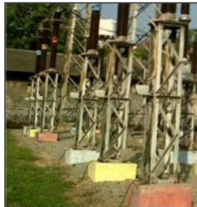
Gambar 2.12 Struktur Penyangga LA
