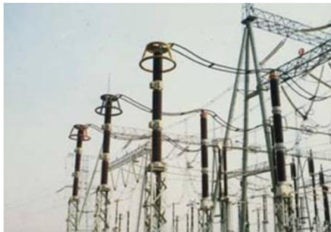
Gambar 2.4 LA di Gardu Induk dengan housing porselen (kiri) dan housing polymer (kanan)
