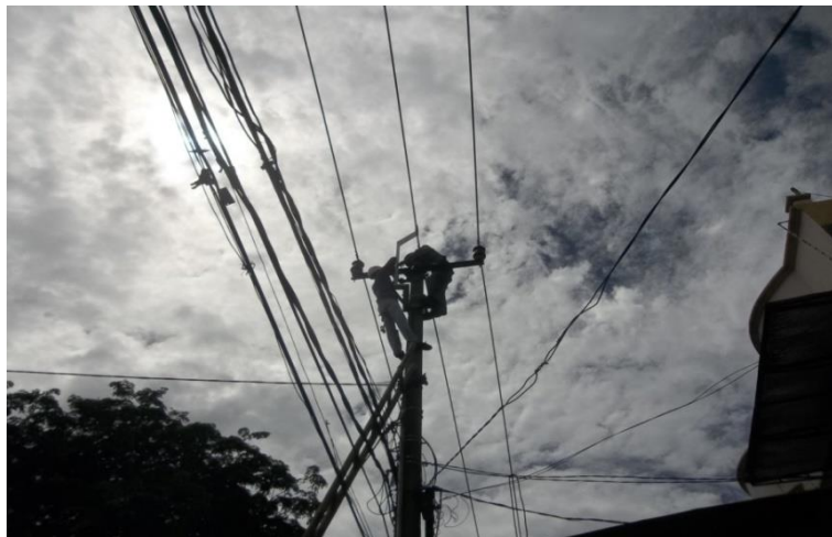
Gambar 3.3 Pemasangan Penyangga UNP
