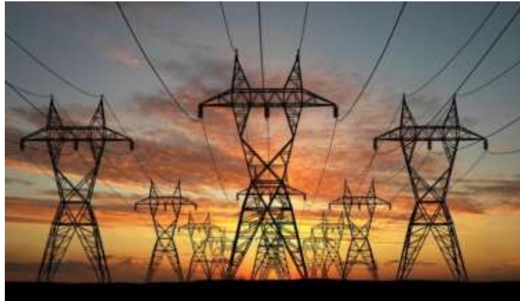
Gambar 2.5 Saluran Udara Ekstra Tinggi (SUTET)
