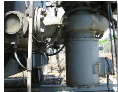
b. Pendinginan dengan motor sirkulasi minyak (Type OFAF)
