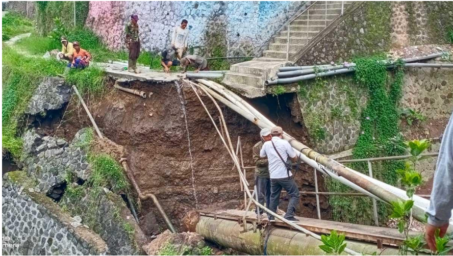
Gambar 39. Kerusakan infrastruktur air bersih akibat cuaca ekstrem (Sumber: seru.co.id )
