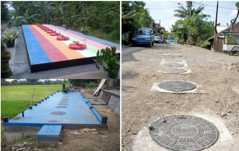
Gambar 14. Dua contoh unit pengolahan ABR di fasilitas SANIMAS (foto kiri), beserta penutup lubang got di area pemukiman yang dilayani sistem perpipaan (foto kanan).
