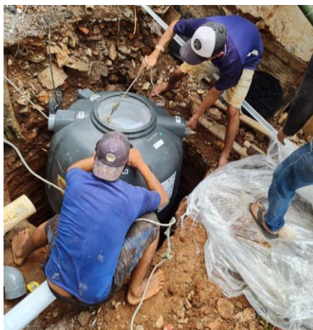
Gambar 28. Pemasangan tangki septik individual (Photo: Rudy Yuwono)
