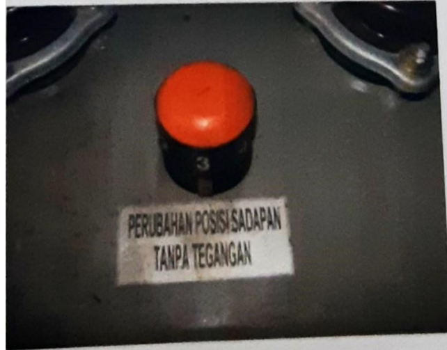
Gambar 2.6 Pengubah Sadapan (Tap Changer)
