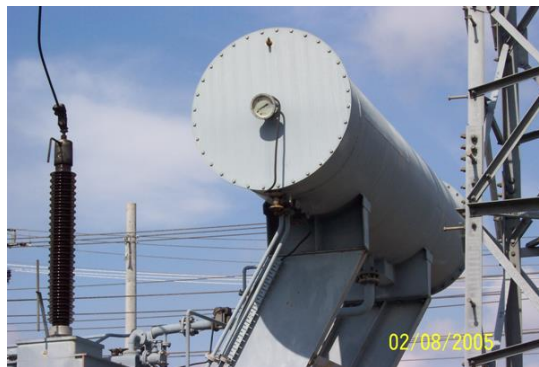
Gambar 2.3 Konservator Transformator
