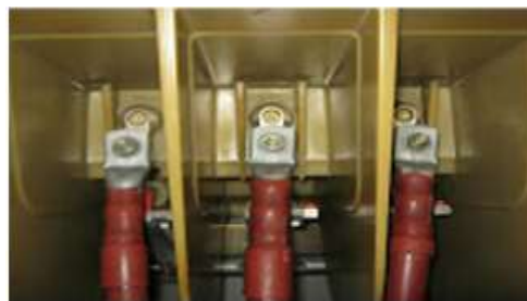
Gambar 2.9. Terminal Penghubung
