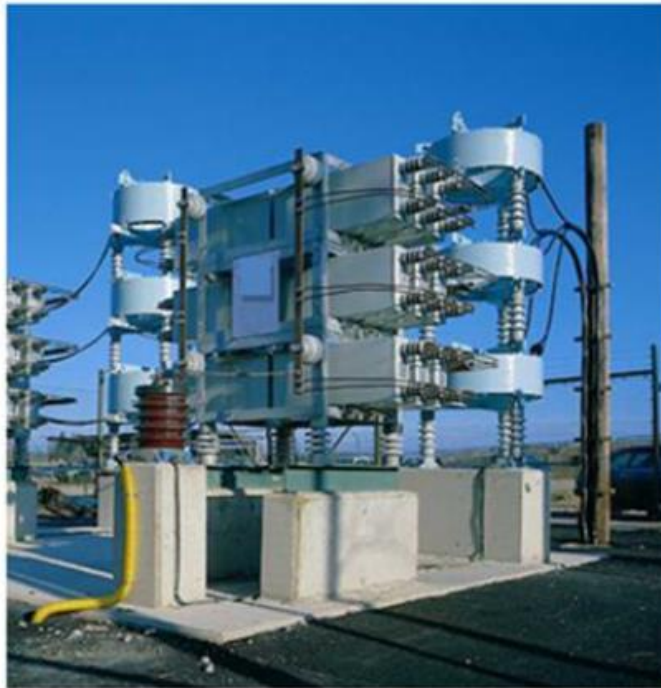
Gambar 2.8 Kapasitor Sebagai Filter Harmonik
