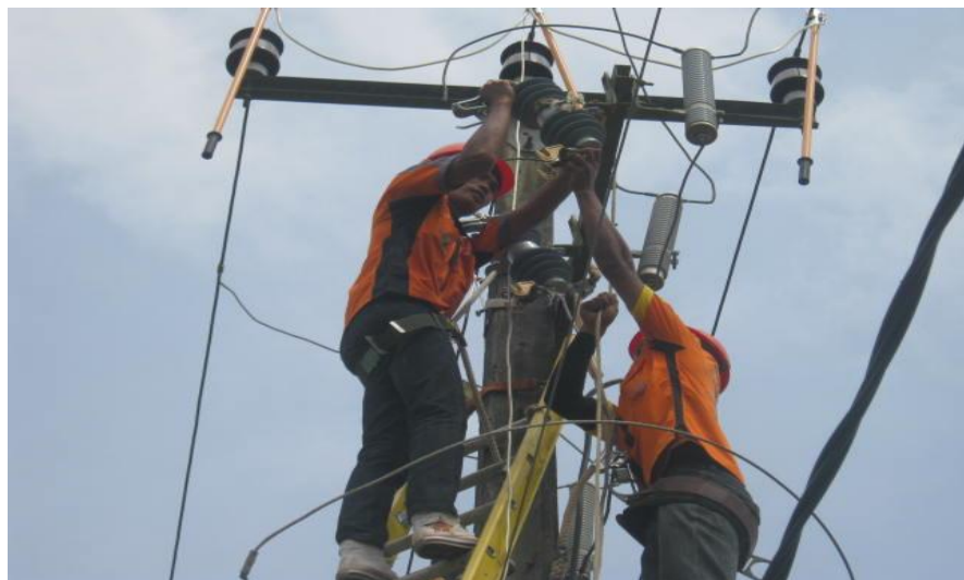
Gambar 4.2 Pemasangan lightning arrester sebelum FCO
