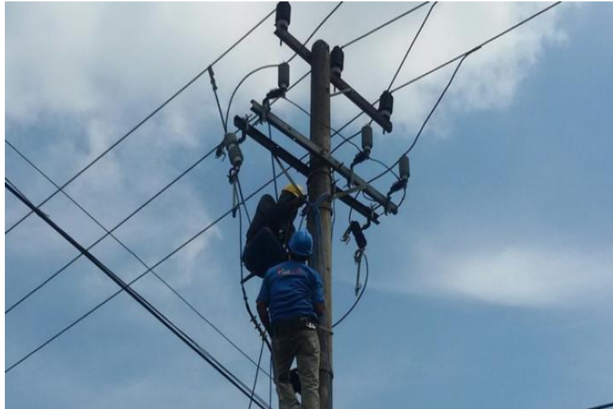
Gambar 4.3 Pemasangan lightning arrester setelah FCO
