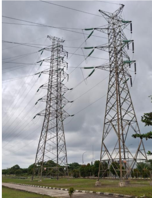
Gambar 2. 3 Tower akhir (dokumentasi pribadi)
