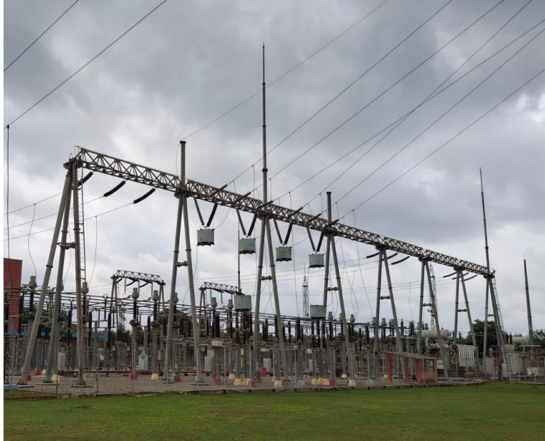
Gambar 2. 6 Tower portal (dokumentasi pribadi)
