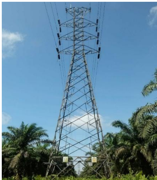
Gambar 2. 1 Menara rangka baja tipe piramida dengan konfigurasi sirkuit ganda (dokumentasi pribadi)
