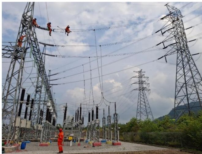
Gambar 2. 10 Tower ujung (dokumentasi pribadi)
