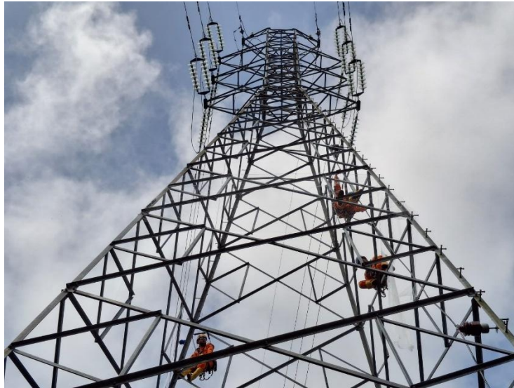
Gambar 2. 9 Tower sudut (dokumentasi pribadi)
