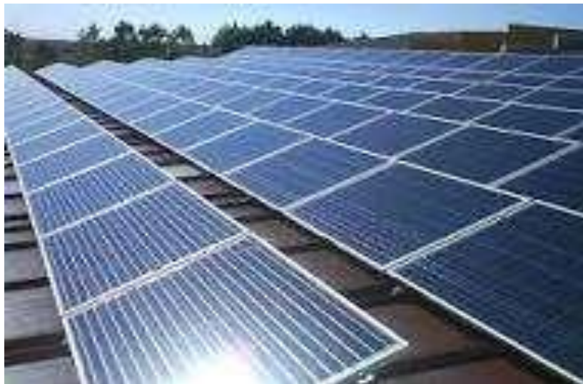
Gambar 2. 1 Pembangkit Listrik Tenaga Surya
