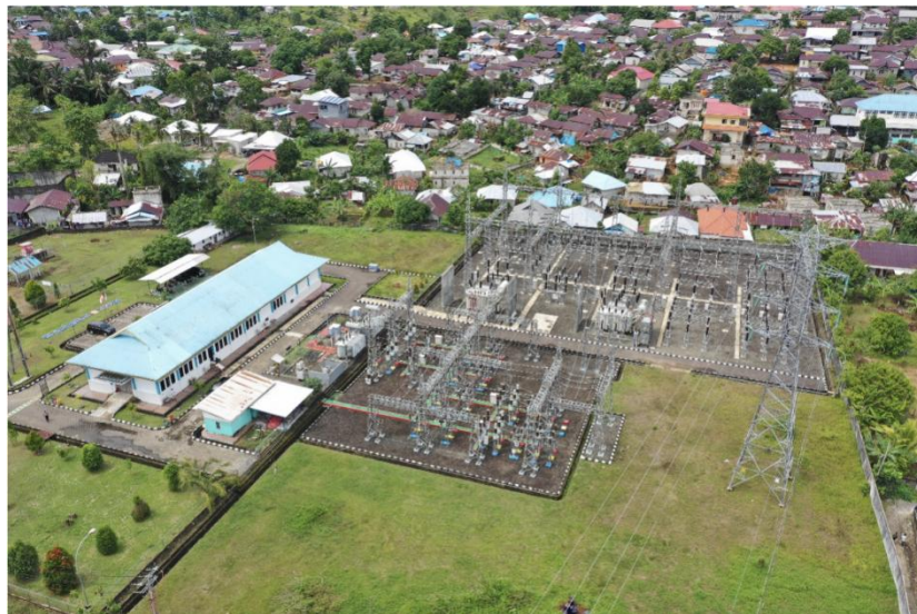
Gambar 2.7 Gardu Induk 150 kV Sirimau
