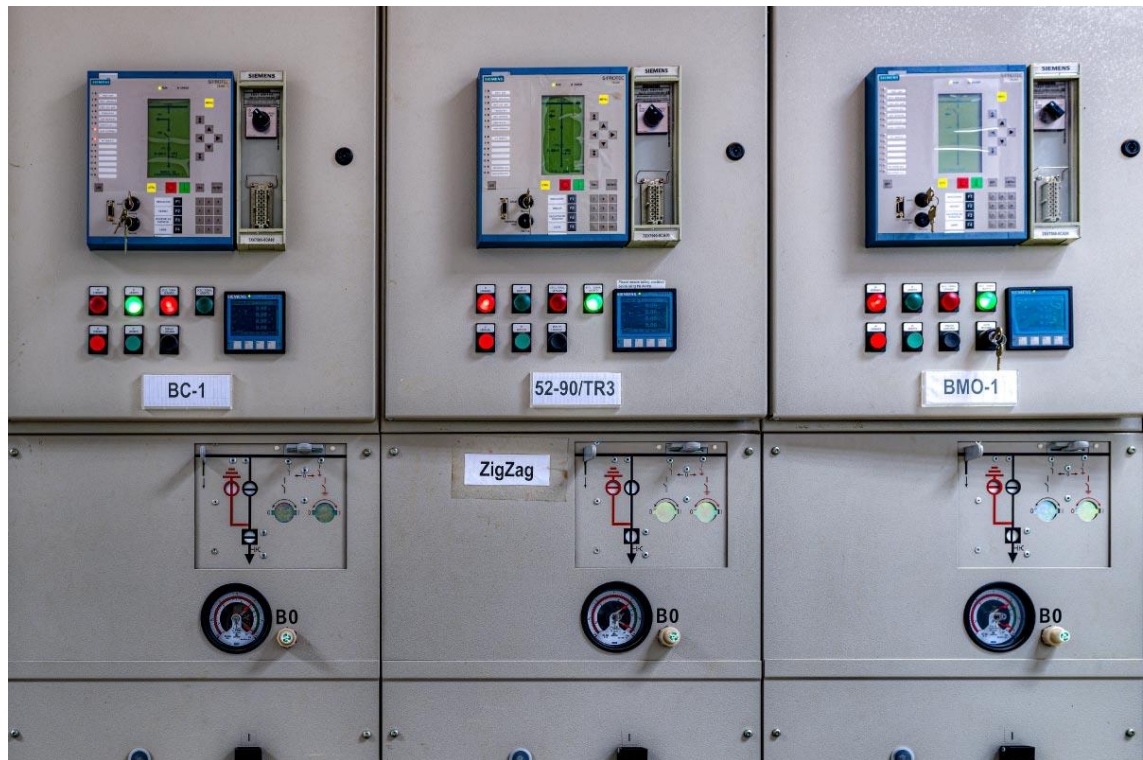
Gambar 2. 10 Kubikel GI 20 kV
