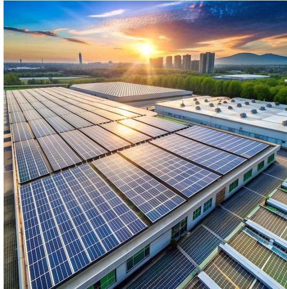
Gambar 2.2. 8 PLTS Atap (Rooftop Solar PV) (Sumber : Freepik)
