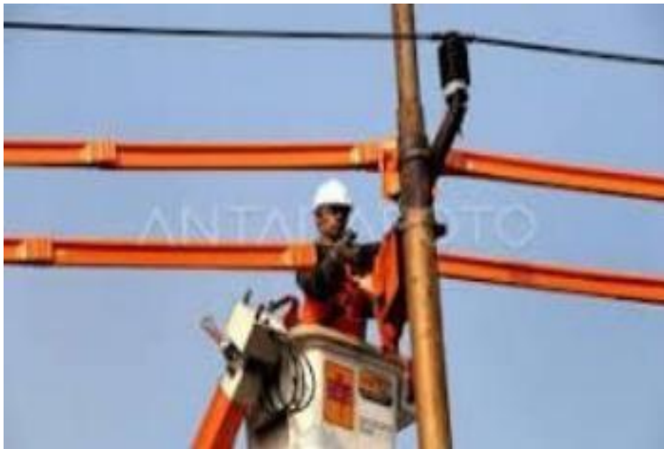
Gambar 2.19 PDKB Metode Sentuh Langsung
