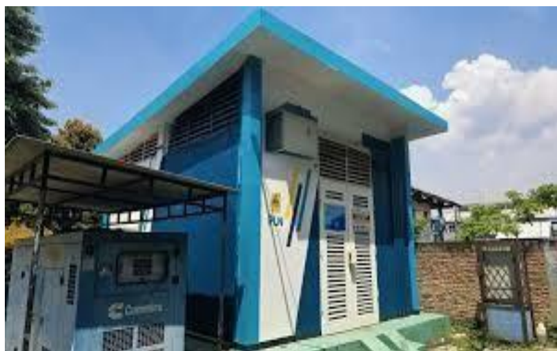
Gambar 2.9 Gardu Beton
