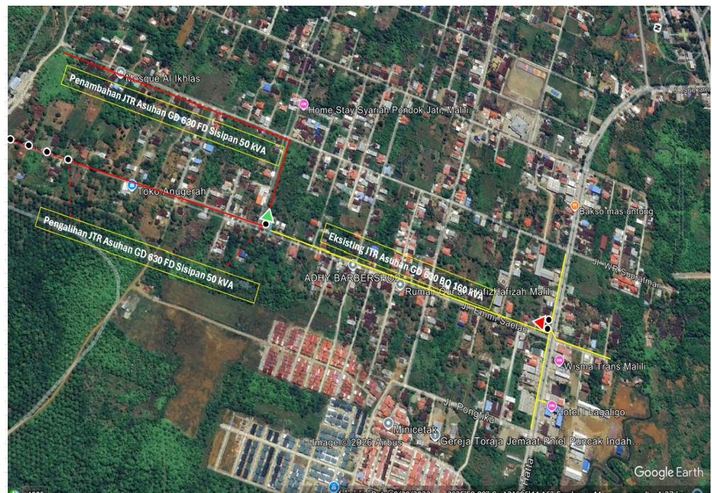
Gambar 4. 8 Jalur JTR Setelah Penambahan Transformator Sisipan
