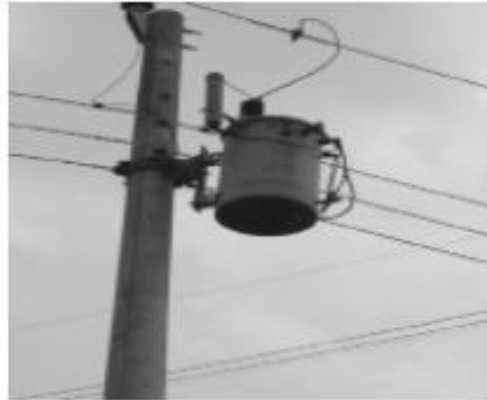
Gambar 2. 4 Gambar Gardu tipe Cantol
