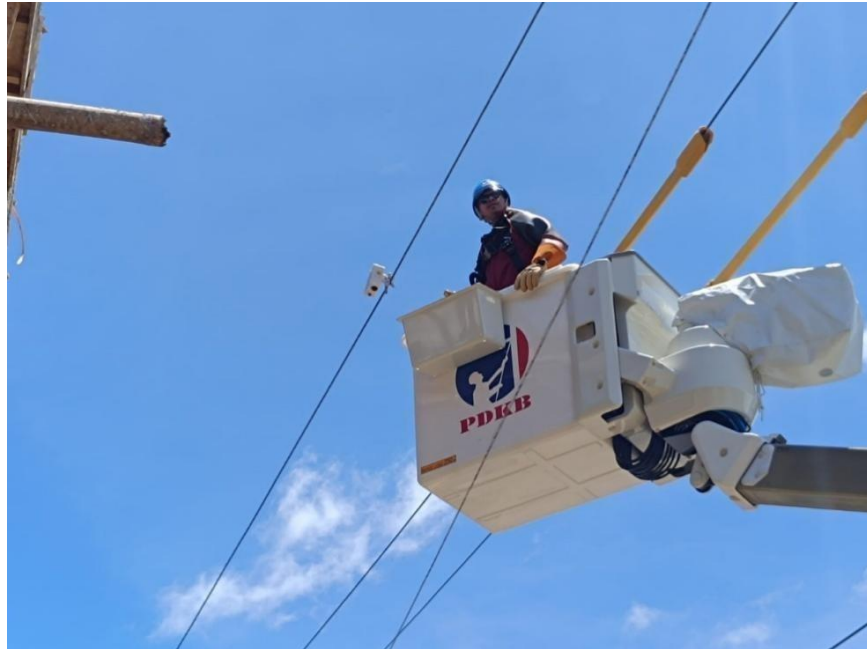
Gambar 2. 6 Pemasangan Inspekta 20kV
