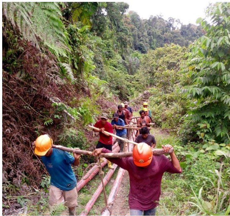
Gambar 2. 21 Proses pengangkutan tiang untuk desa terpencil
