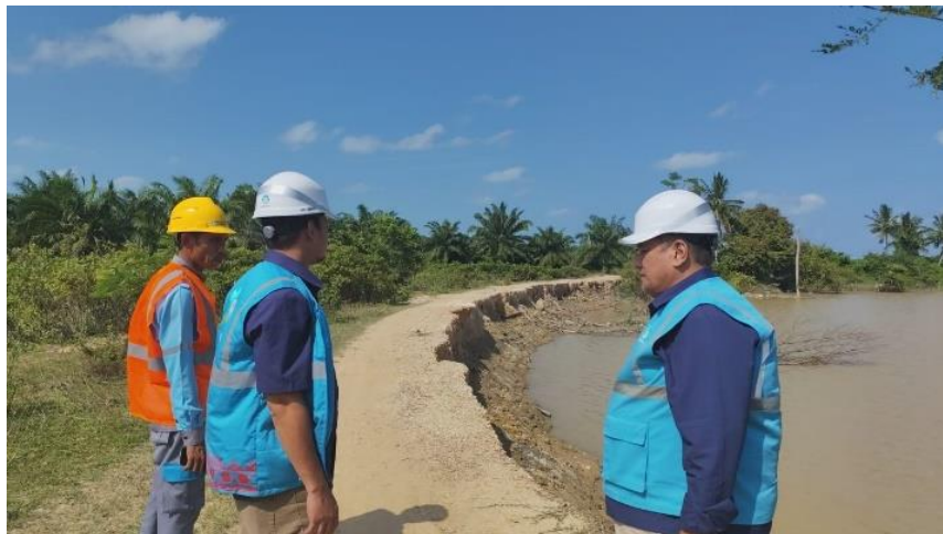
Gambar 2. 20 Proses survey rencana pembangunan jaringan listrik desa
