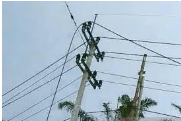
Gambar 2.20 Gangguan Pada SUTM Akibat Konduktor Putus Atau Lepas
