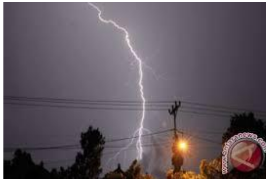
Gambar 2.18 Gangguan Pada SUTM Akibat Petir (Surge Lightning)
