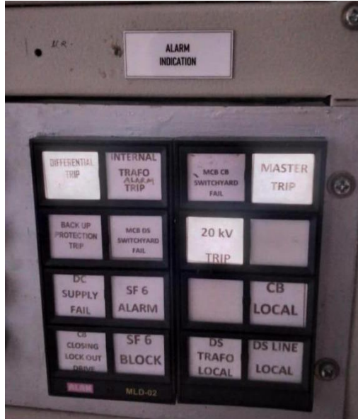
Gambar 3.11 Indikasi Alarm Pada Panel Proteksi gangguan pertama
