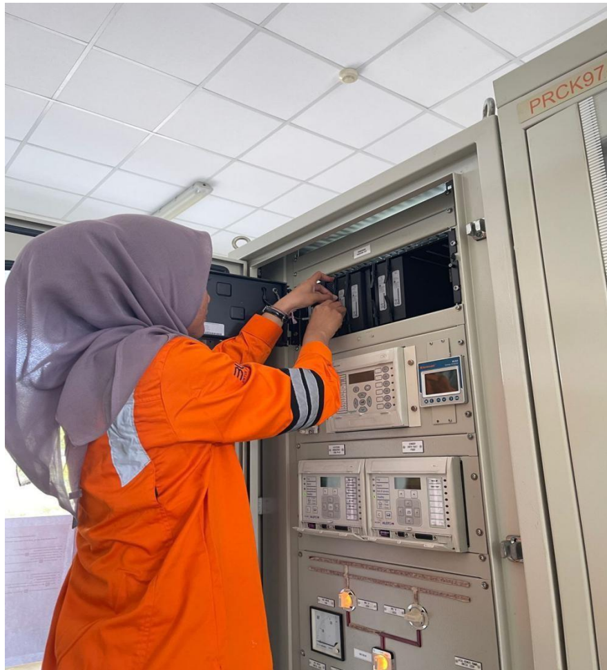
Gambar 4.8 Proses Penggantian Modul CT dan Modul Power Supply
