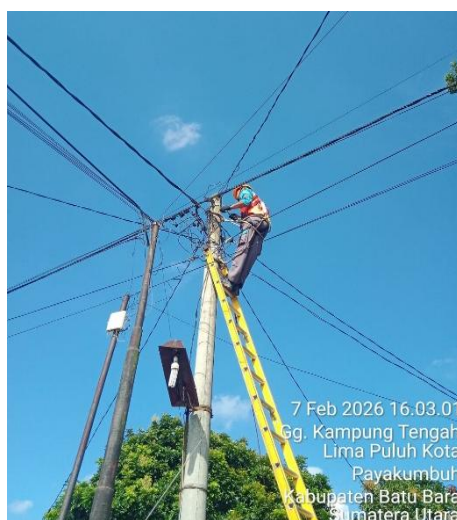
Gambar 2.2. Jaringan tegangan rendah (TR)
