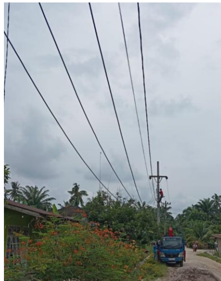
Gambar 2.21. Pemasangan kabel dan penarikan kabel
