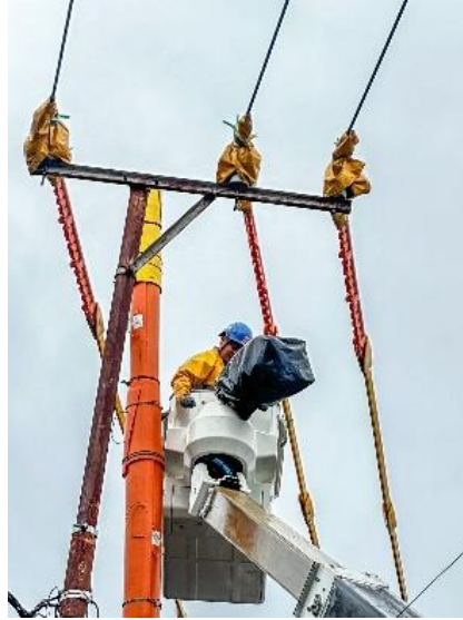
Gambar 2. 3 Pekerjaan Dalam Keadaan Bertegangan (PDKB)
