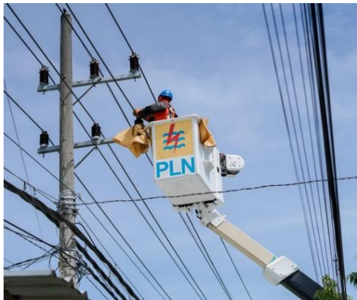
Gambar 2. 25 Pekerjaan PDKB TM
