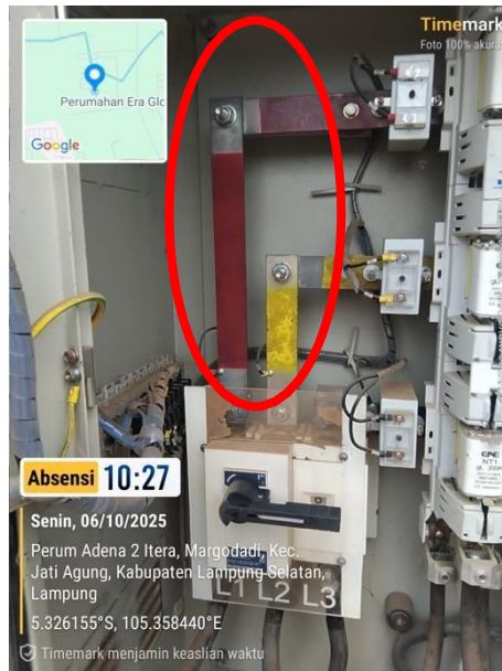
Gambar 2. 13. Busbar Rail Sumber: Dokumentasi Pribadi
