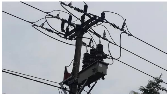
Gambar 10. Recloser (Pemutus Balik Otomatis)
