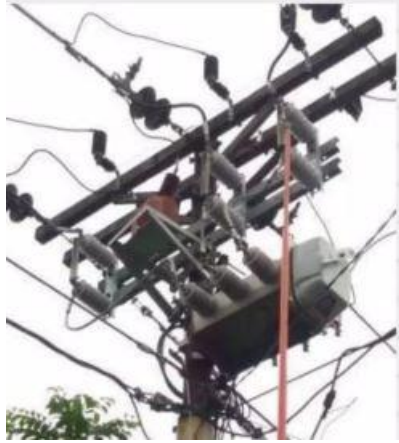
Gambar 11. Sectionalizer (Saklar Seksi Otomatis)
