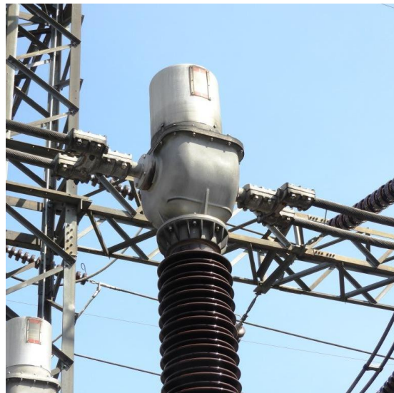
Gambar 2.3 Current Transformer (Dokumentasi Pribadi)
