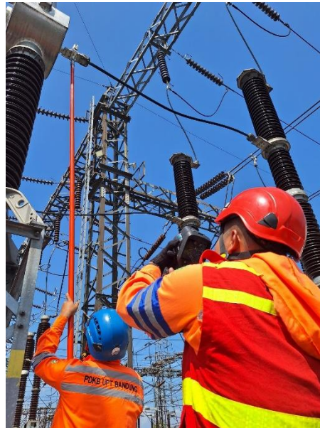
Gambar 2.17 Proses Pemasangan Sandwich Clamp
