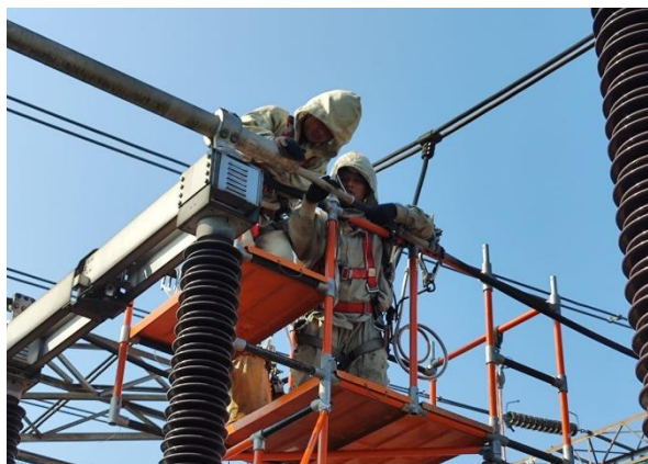
Gambar 2.10 Pelaksanaan Pekerjaan Dalam Keadaan Bertegangan.
