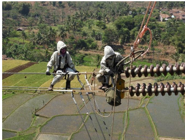
Gambar. 2.11 Metode Barehand pada Pekerjaan Dalam Keadaan Bertegangan
