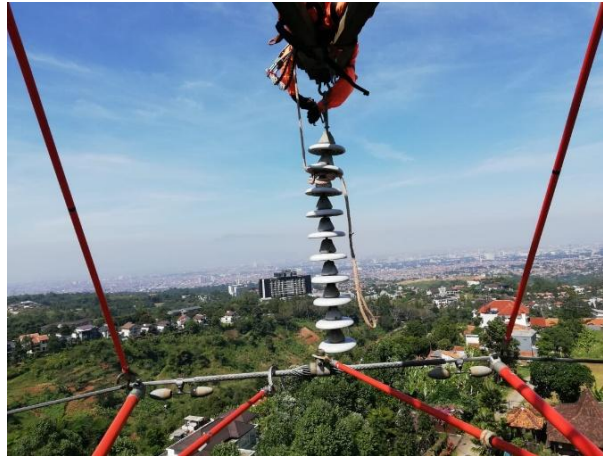
Gambar. 2.12 Metode hotstick pada Pekerjaan Dalam Keadaan Bertegangan
