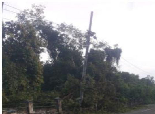
Gambar 2.11 Gangguan penyulang bersifat permanen.
