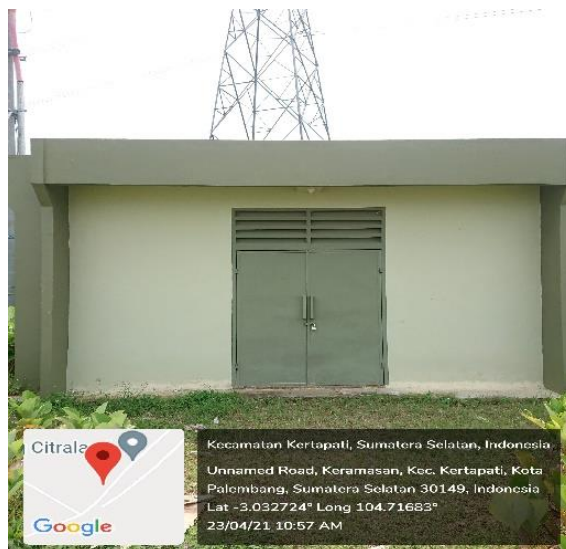
Gambar 2.9 Gardu beton
