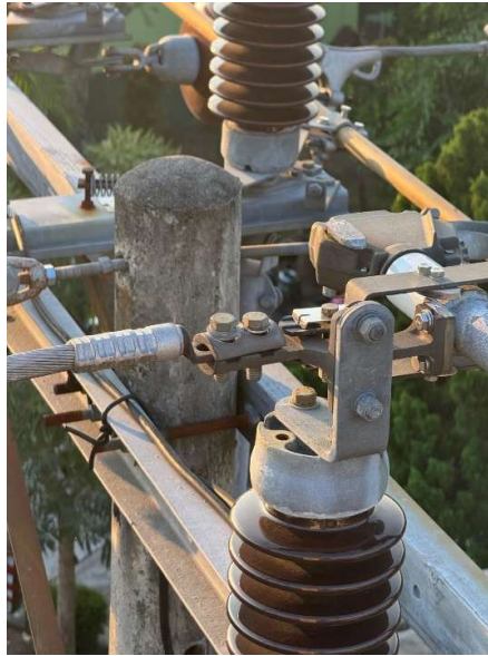
Gambar 4.18 Kondisi Kontak ABSW
