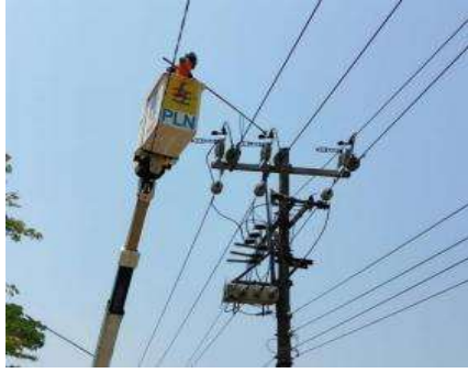
Gambar 3.1 Pelumasan ABSW PDKB-SL
