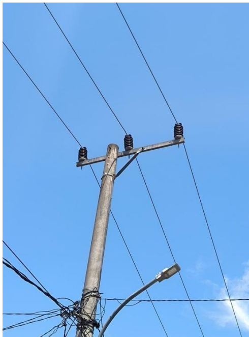
Gambar 4.6 Isolator Post Setelah Penggantian pada Penyulang Roro
