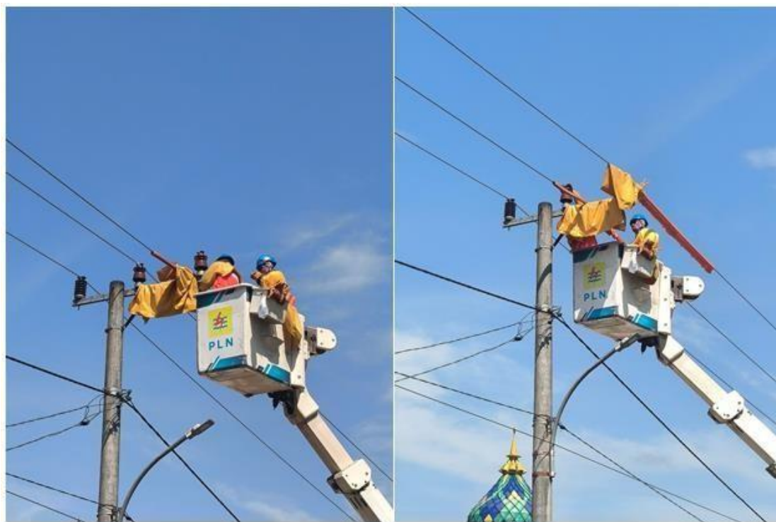
Gambar 4.2 Pengerjaan Pemasangan Isolator Tumpu
