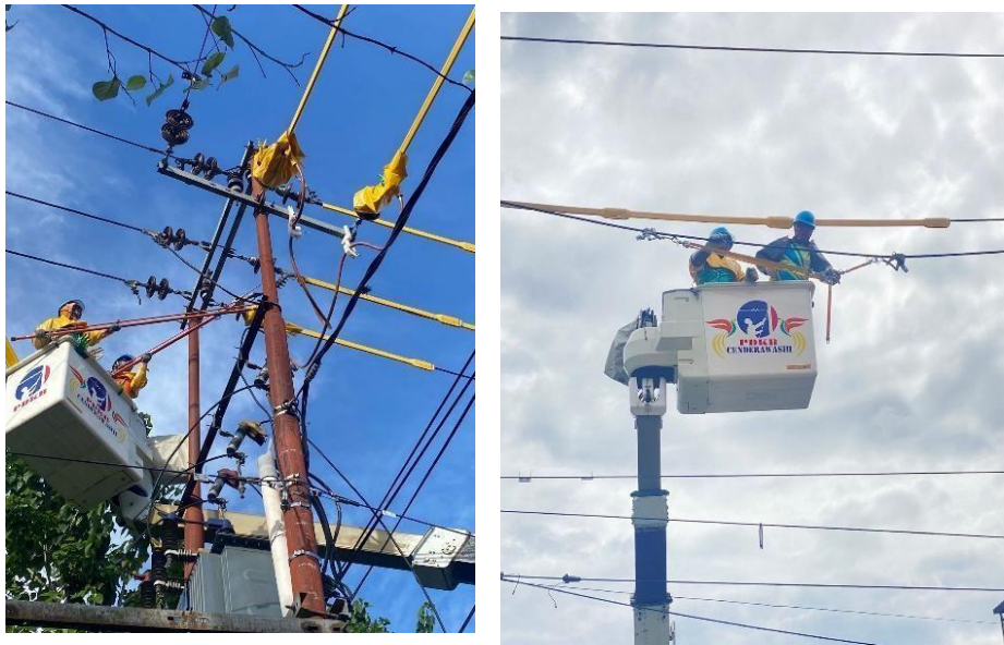
Gambar 2. 11 Pekerja Dalam Keadaan Bertegangan
