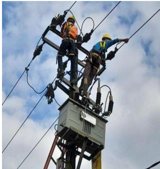
Gambar 2. 12 Pekerjaan Non - PDKB
