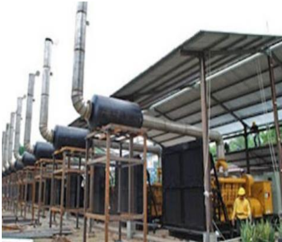
Gambar 2.10 Keluar Gas Buang
