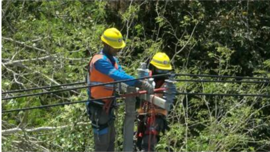
Gambar 2. 16 Pemeliharaan korektif penggantian isolator Flashover
