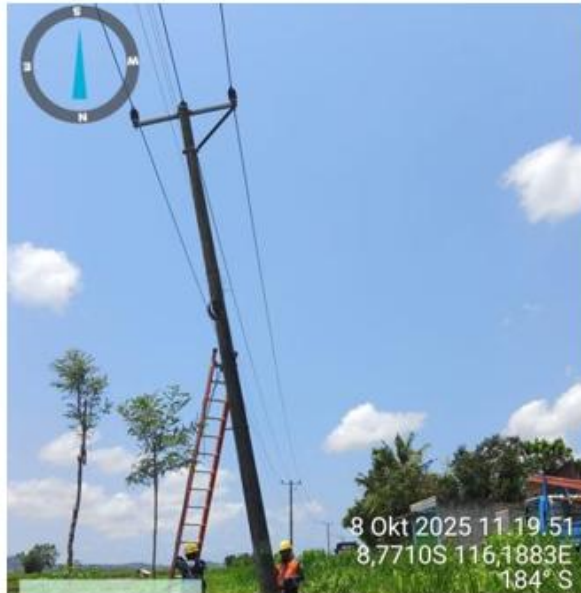
Gambar 2. 15 Pemeliharaan Rutin pelurusan tiang miring tanpa padam
