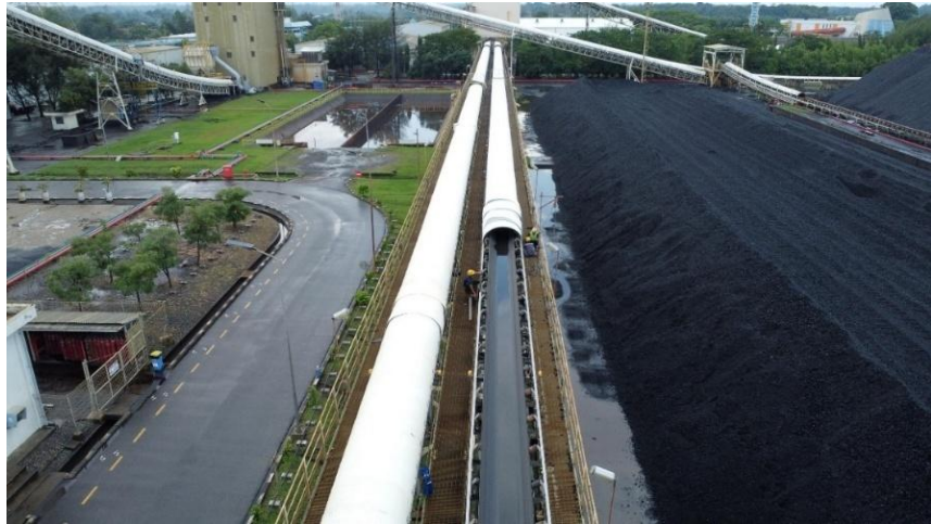
Gambar 2.17 Conveyor dari Coal yard menuju Coal Silo
