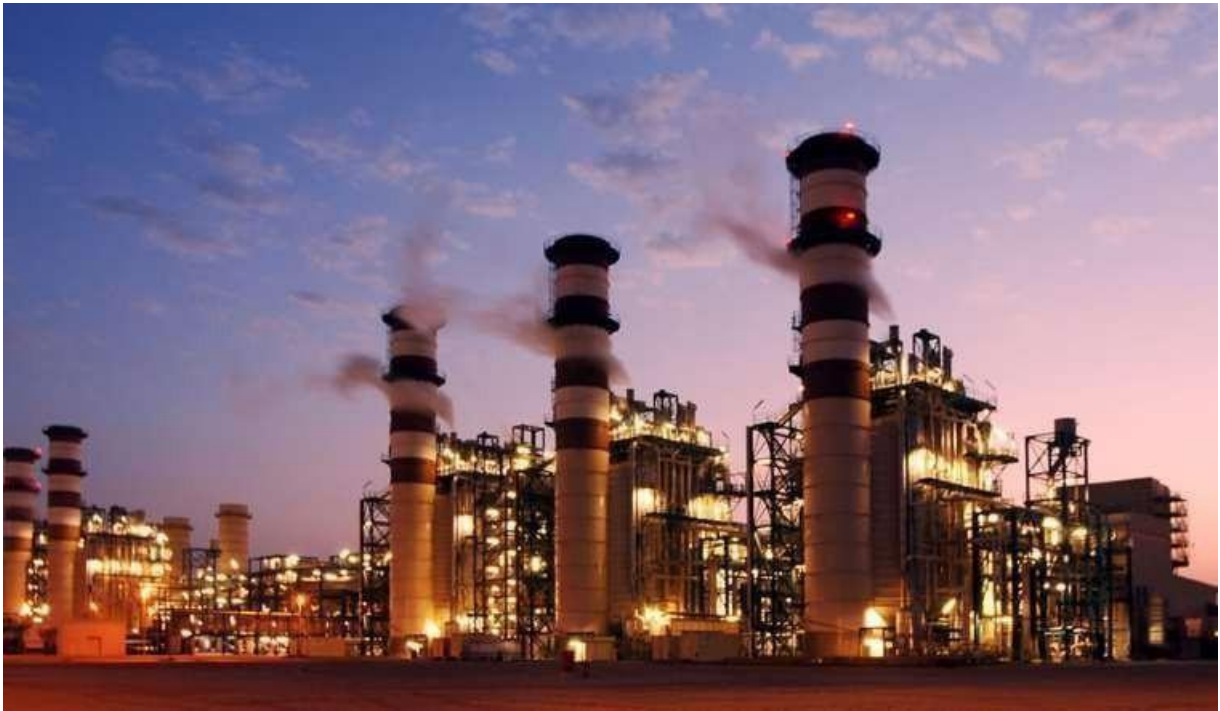
Gambar 2. 18 Pembangkit Listrik Tenaga Uap (PLTU)
