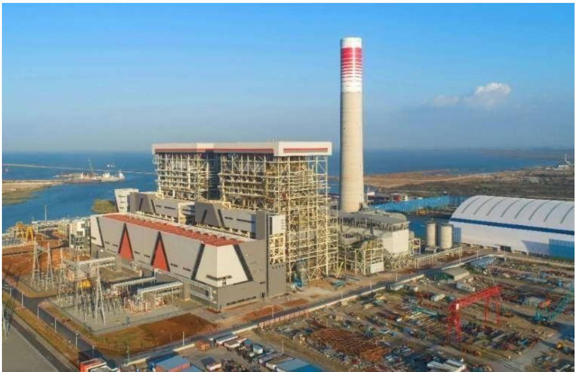
Gambar 2. 1 Pembangkit Listrik Tenaga Uap
