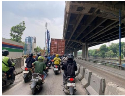
Gambar 2. 1 Ruas Jalan Arteri R.E. Martadinata (Sumber : Dokumentasi Pribadi, 2025)
