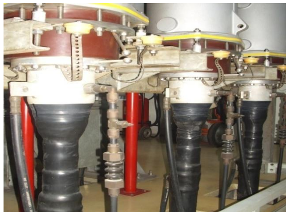
Gambar 2.6: Terminasi pada Sealing End Cable (model busbar 1 enclosure – 1 phase)
