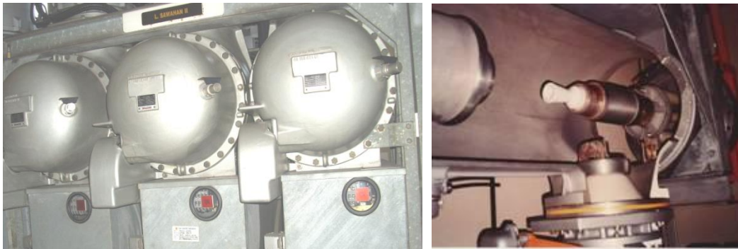
Gambar 2.1: Kompartemen Pemutus Tenaga (model busbar 1 enclosure – 1 phase)
