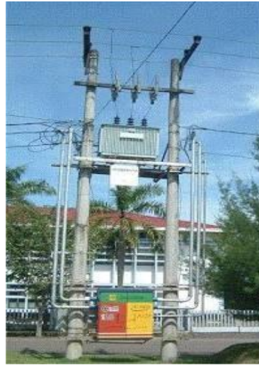
a. Gardu Portal
