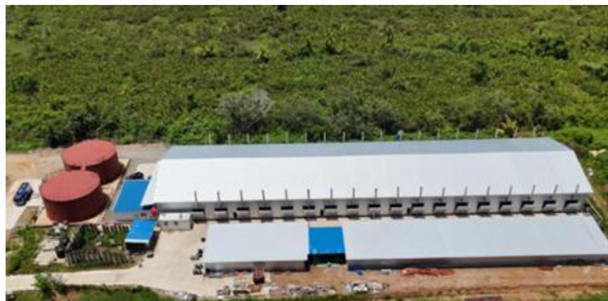
Gambar 2.1 Pembangkit Listrik Tenaga Diesel
