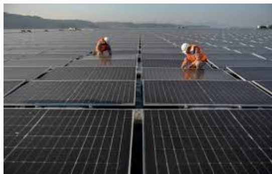
Gambar 2. 2 Pembangkit Listrik Tenaga Surya
