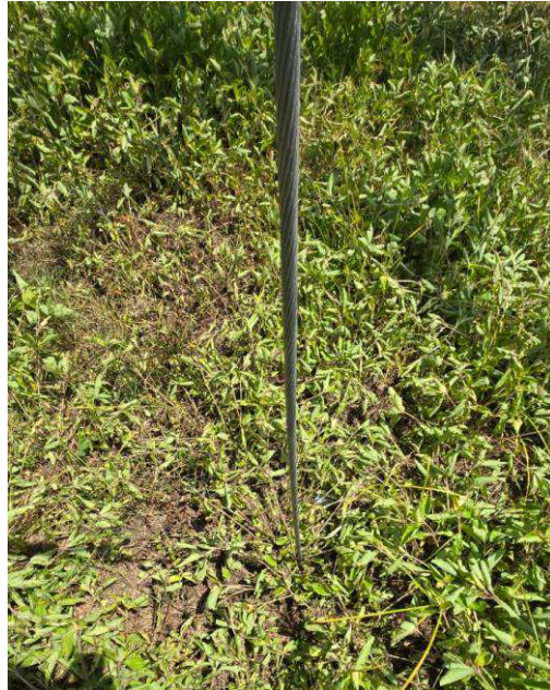
Gambar 2. 14 Rod Pentanahan SUTT Sumber: Dokumentasi Pribadi
