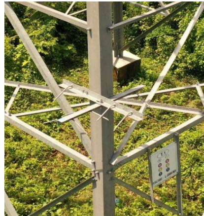
Gambar 2. 11 ACD pada SUTT
