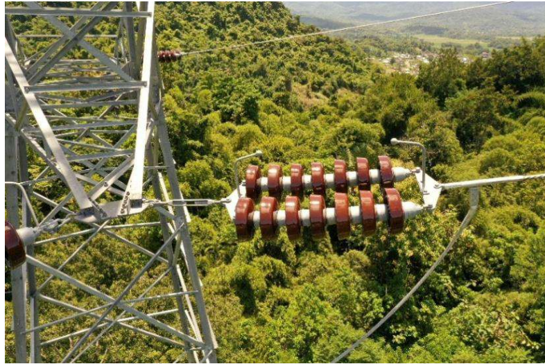
Gambar 2. 15 Arching pada Isolator SUTT
